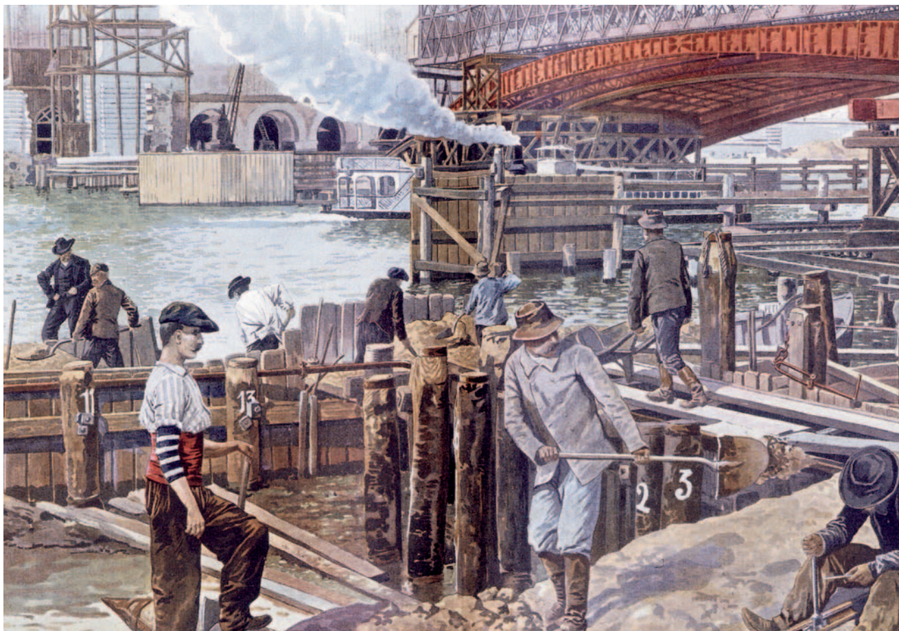
Construction du pont Alexandre III. – Exposition universelle de 1900.
