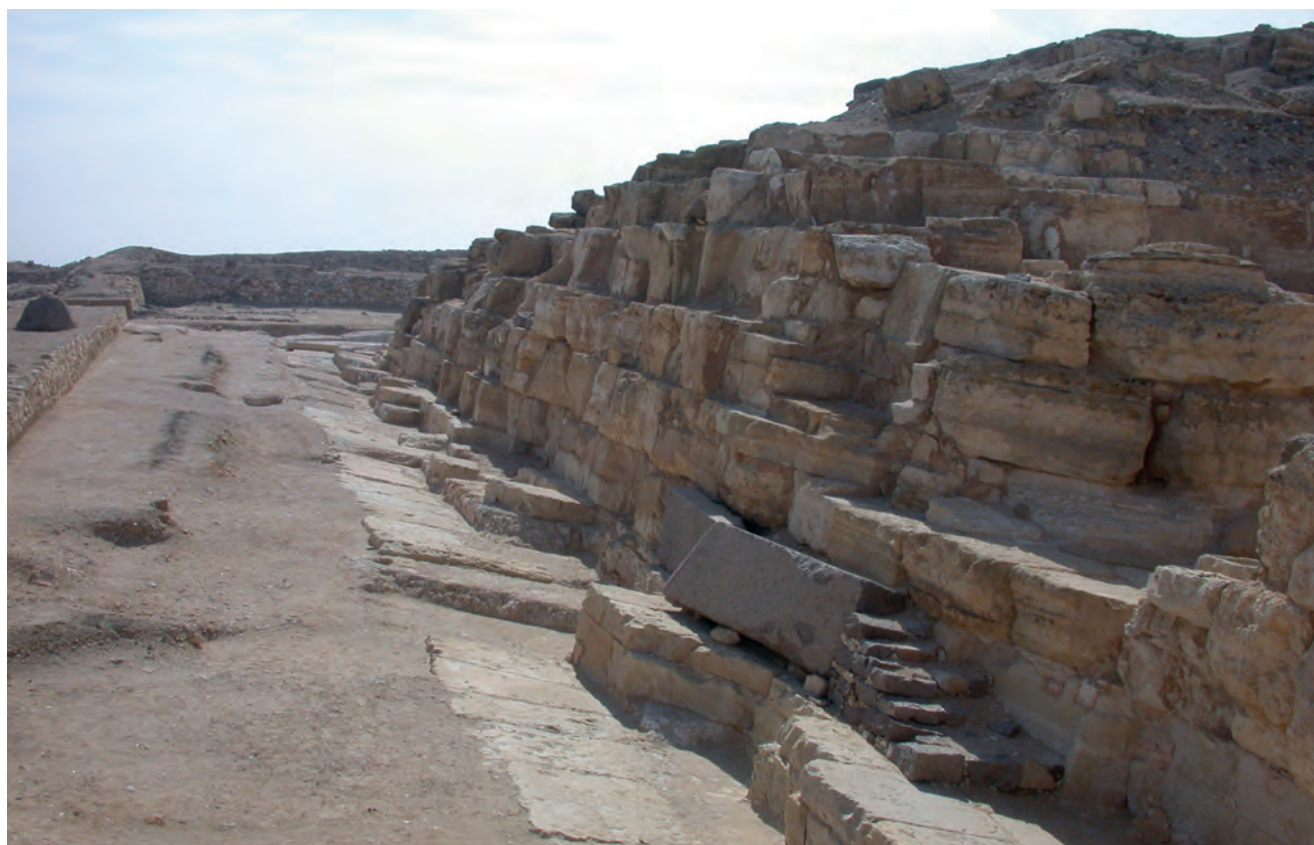
Ill. 3 – Le lit de fondation déversé de la face nord, vue en direction de l'est
