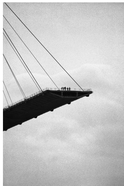
Construction du Pont de Normandie, 1993
