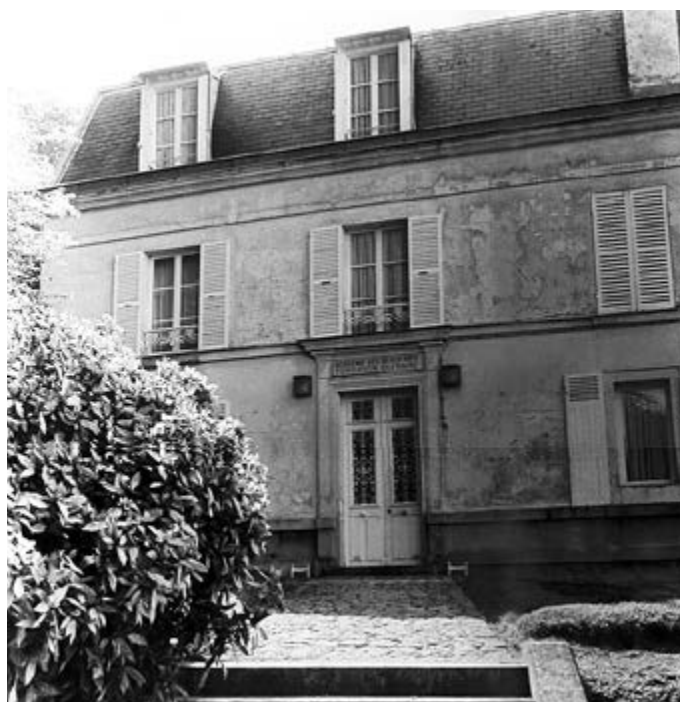
Page 1 et ci-contre : Fondation Dufraine à Chars, bâtiment principal
