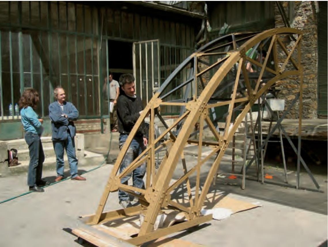
Assemblage, dans une fonderie, d'une structure, copie d'une pièce de la Tour, pour les besoins du film. Photo DR
