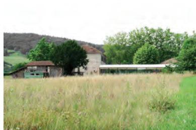
↓ E26, réfectoire scolaire à Montbrun-Bocage © BAST
