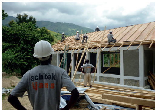
Haiti chantier © Architectes de l'urgence
